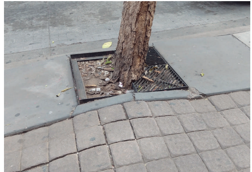
Fotografía 48. La mala selección de arbolado para la banqueta desencadena problemas como banquetas levantadas o fracturadas y daño a los elementos superficiales y subterráneos.
