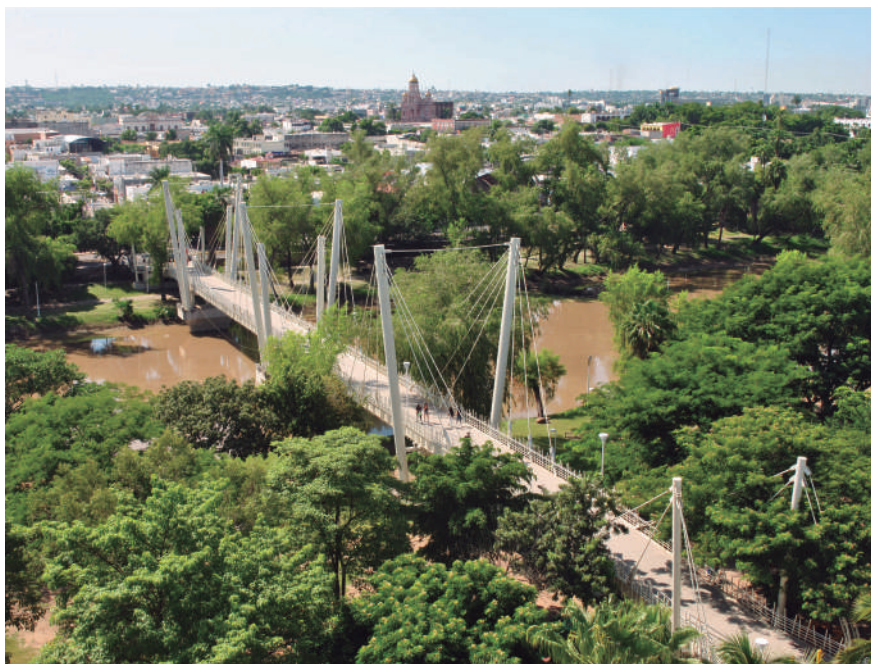
Fotografía 53. Parque las Riberas, se observa como la copa de los árboles cubren parte de el Puente Bimodal Morelos, Culiacán, Sinaloa.
