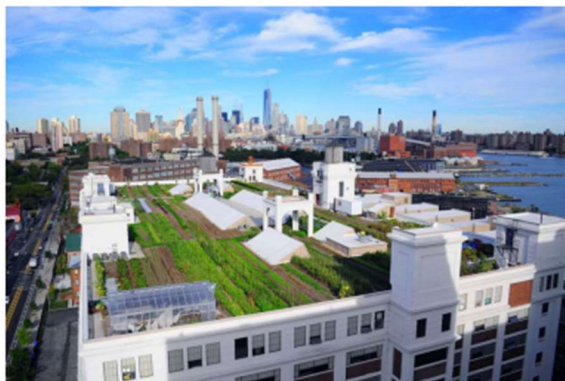
Los techos son el nuevo campo Ej. Brooklyn Grange Navy Yard Farm, NY EUA (una de los espacios productivos en un techo mas grandes del mundo – 0.6 ha)
